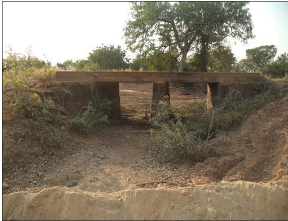
LOT n°4 : Région de la Kara _ pont à remplacer (état initial)
