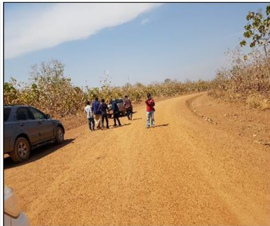
LOT n°4 : Région de la Kara _ piste en rase- campagne (fin des travaux)
