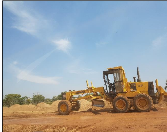
LOT n°4 : Région de la Kara _ travaux de remblai (phase travaux)
